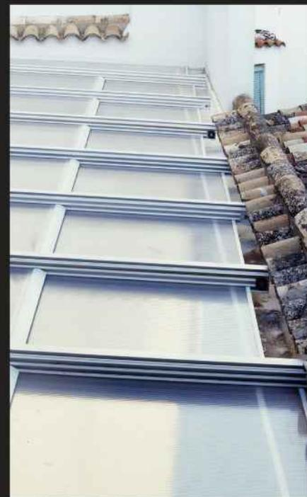
**SKYGALLERY** es una completa gama de techos fijos con los que se cubre una gran variedad de necesidades. Son estructuras sencillas pero de gran resistencia y durabilidad. La cubierta superior puede ser de cristal sencillo, policarbonato o paneles sandwich con distintos acabados.
